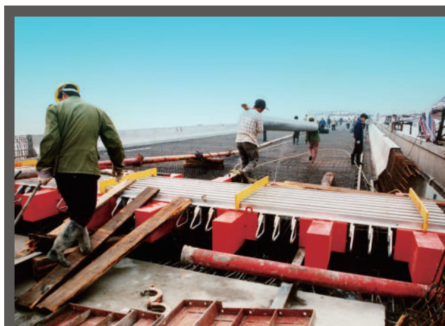
Применение деформационных швов при строительстве Хебейского автомобильного моста
