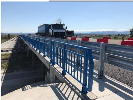
Рядовая секция перильного ограждения в месте установки деф. шва
