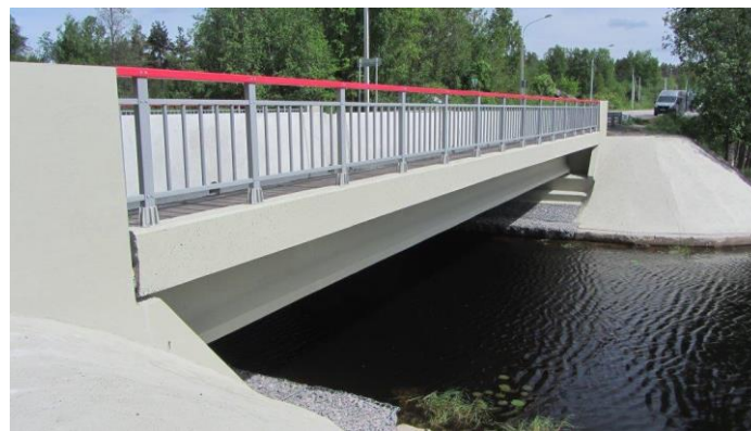
Рядовая секция перильного ограждения
